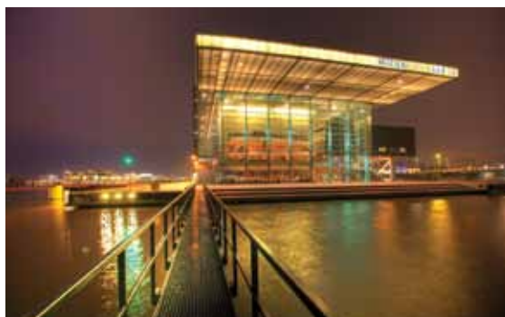
Muziekgebouw aan 't IJ, Amsterdam
